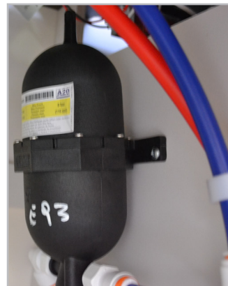
Fig. 7.2 - Vaso do espansione
